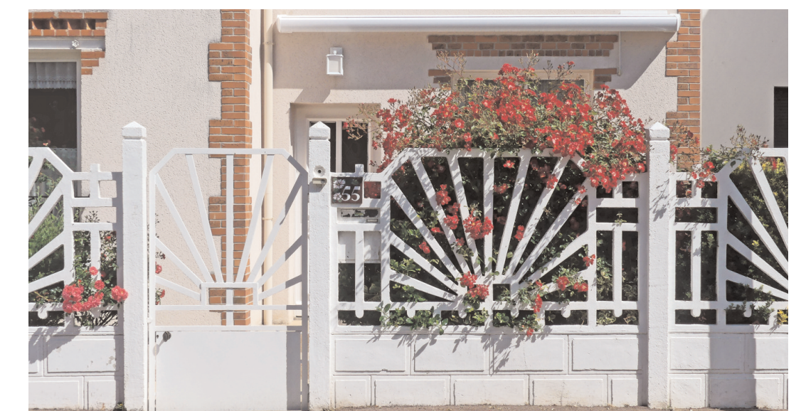
La clôture en ciment est particulière et, selon les préconisations du PLU, est considérée comme typique d'une époque et il faut conserver le peu d'exemple qui subsistent.
